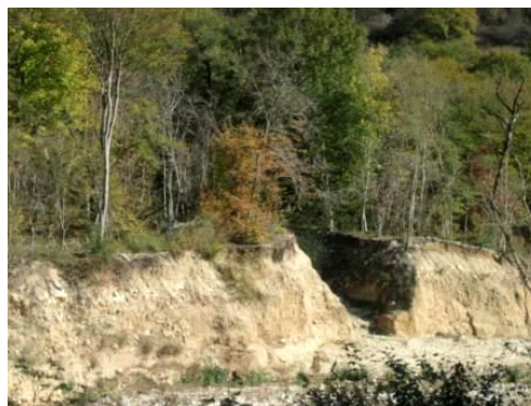
شکل (۹): ایجاد دیواره‌های عمیق و عمودی که گذر و تردد حیات وحش را ناممکن ساخته است (منبع: نگارندگان)
